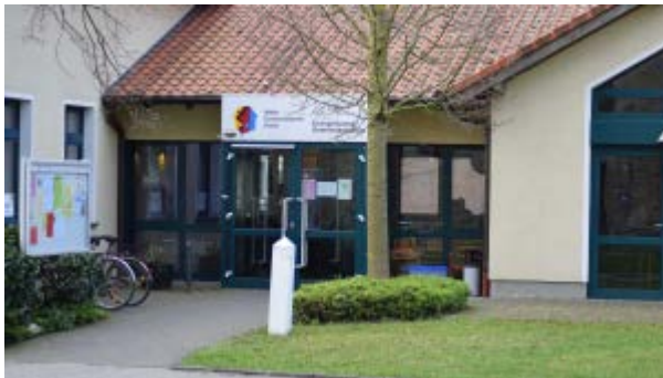
MGH – Eingang Kirchplatz
